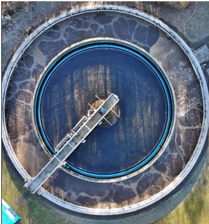
Réacteur biologique (anneau extérieur) et clarificateur (intérieur)
